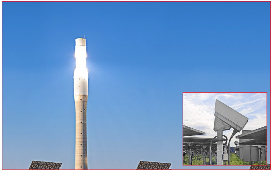
Solarturm-Kraftwerk – Überwachung der optimalen Wärmeverteilung mithilfe von Infrarotkameras von InfraTec
